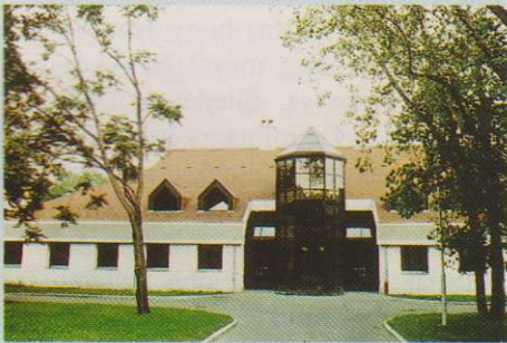
A nyíregyházi műveseállomás épülete
