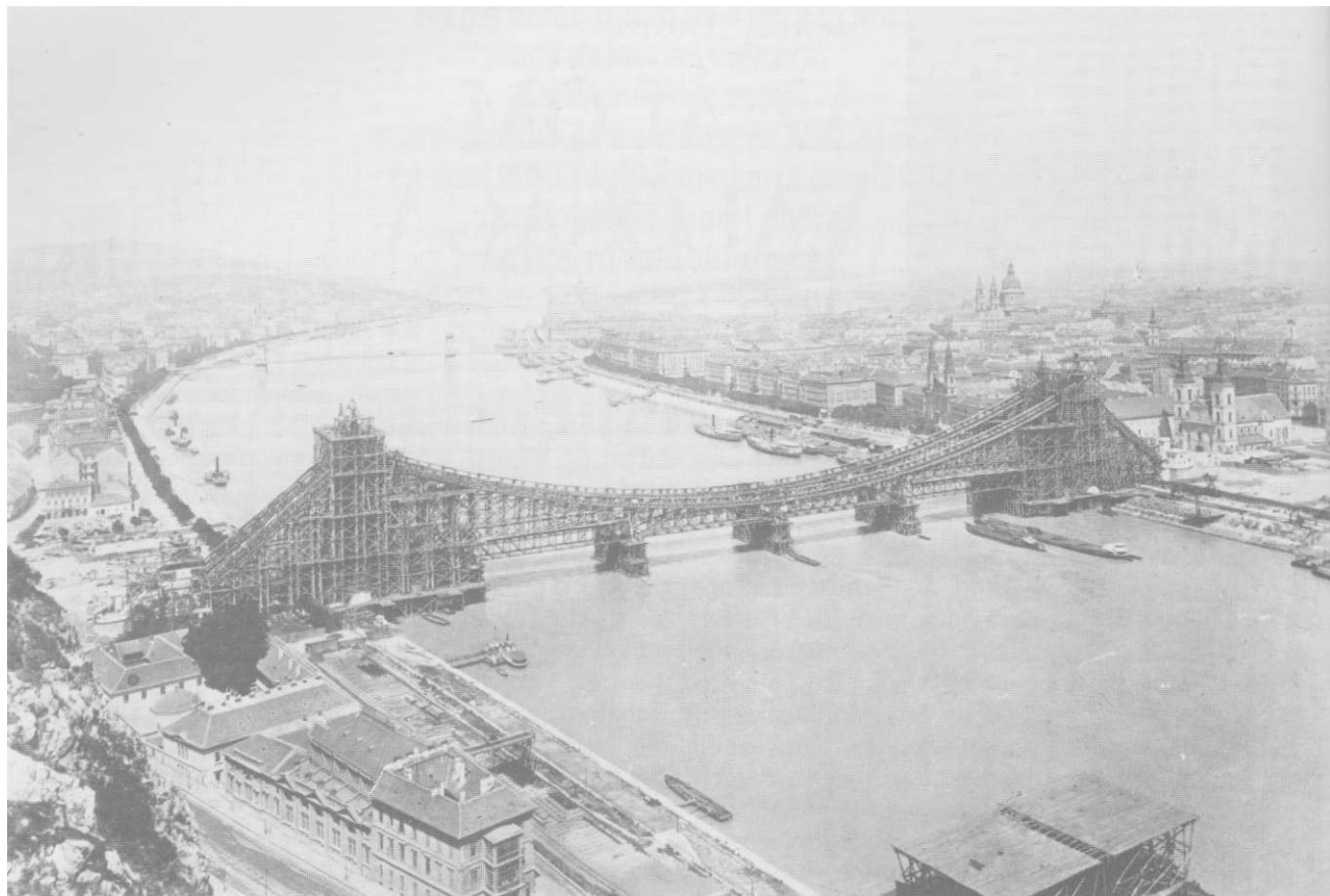
Az Erzsébet-híd építése 1903-ban
