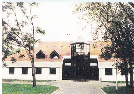
A nyíregyházi műveseállomás épülete
